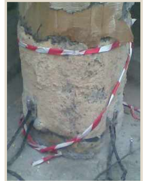
Posisi sensor tidak berhadapan 180° berimbas pada 'bending'
