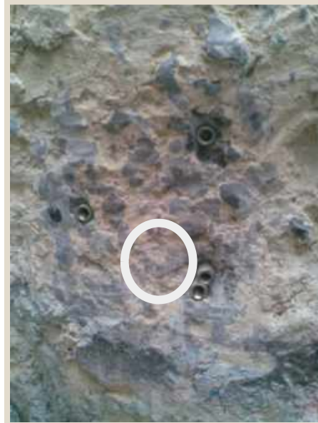
Permukaan yang tidak rata dan lubang bor yang asal-asalan
